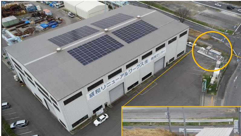
納入した再生エネルギー設備
